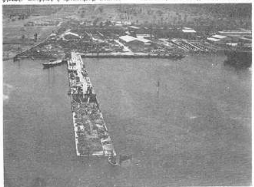
Άποψις των «Έλληνικών Ναυπηγείων», με την κατασκευασθείσαν προβλήτα.
